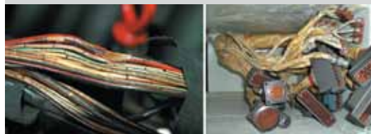
Рис. 2 Дефекты монтажа жгутов – плохое изолирование проводов и дефекты пайки разъемов
