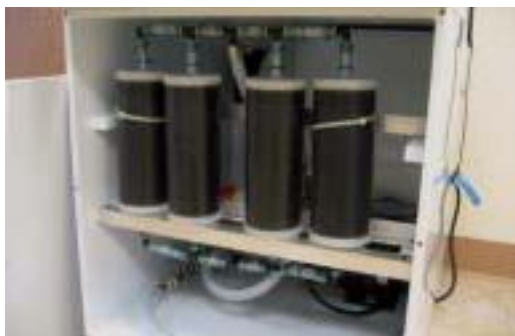
Рис. 3. Ионообменные колонки
